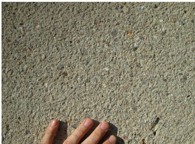
dettaglio di cemento bocciardato
