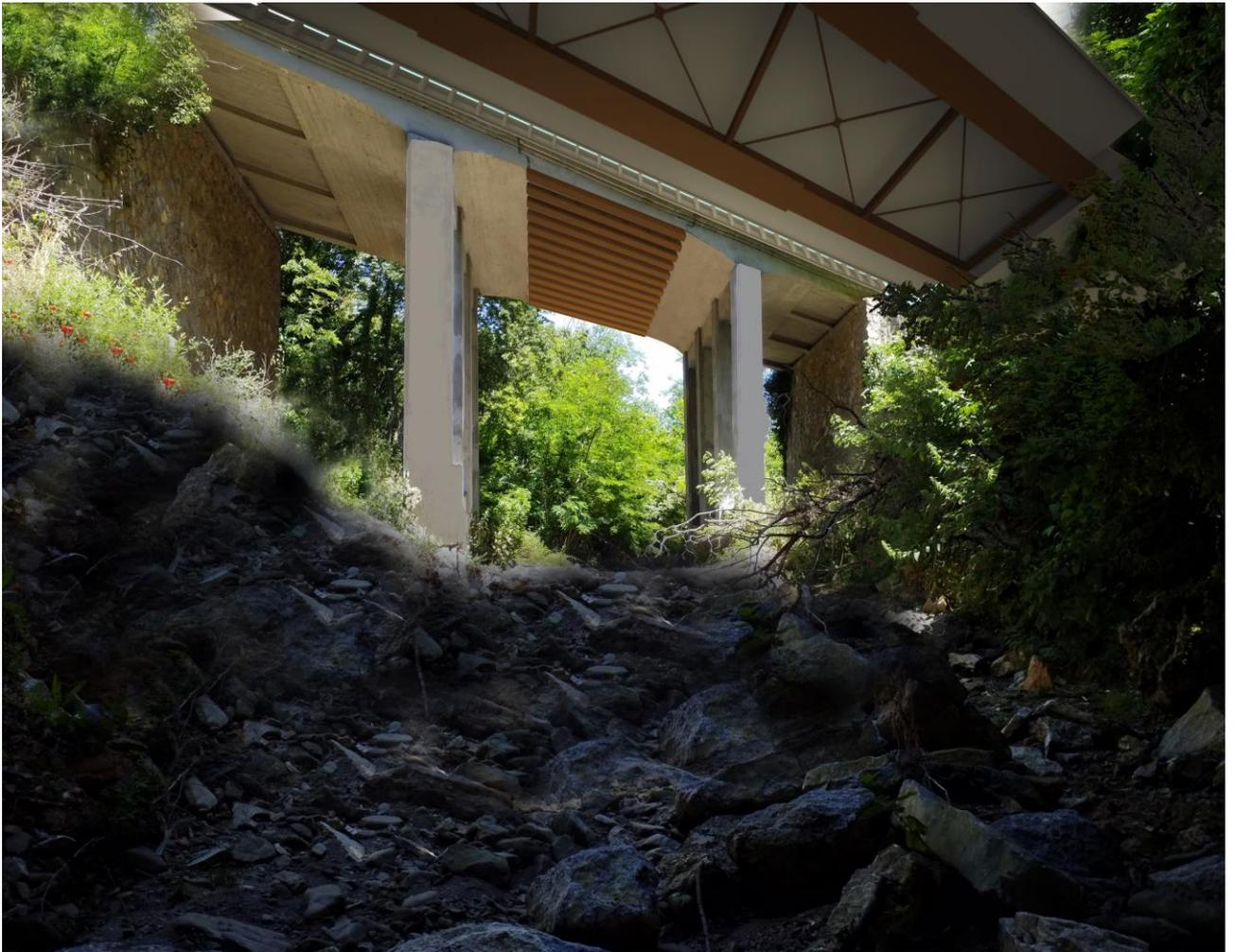
La realizzazione di un impalcato di 36 metri di luce permette una minima invasione dell'alveo del corso d'acqua. Inoltre la necessaria protezione delle fondazioni con scogli naturali, già presenti nell'alveo, riduce l'impatto visivo delle opere stesse.
