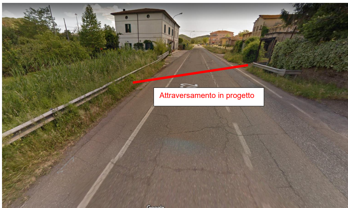
Figura 2.1: stato attuale in prossimità dell'attraversamento in progetto della S.P. n.152
