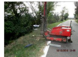
Foto 8a - Fase di realizzazione prova penetrometrica DPSH8
