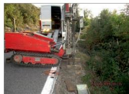
Foto 1a - Fase di realizzazione prova penetrometrica DPSH1
