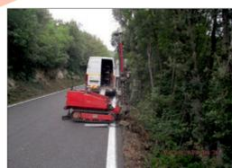
Foto 5a - Fase di realizzazione prova penetrometrica DPSH5
